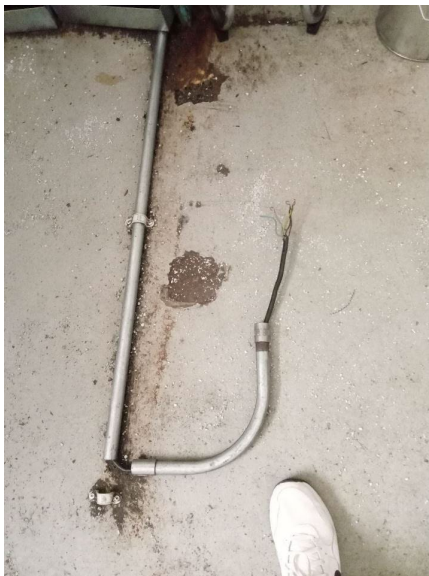
Obrázek č. 15 - Volně visící používané kabely pod napětím
