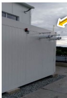
Obrázek č. 21 - Odvod spalin přes stěnu objektu kotelny (s 2x 85 kW)
