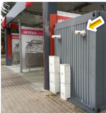
Obrázek č. 21 - Odvod spalin přes stěnu objektu kotelny (s 2x 85 kW)
