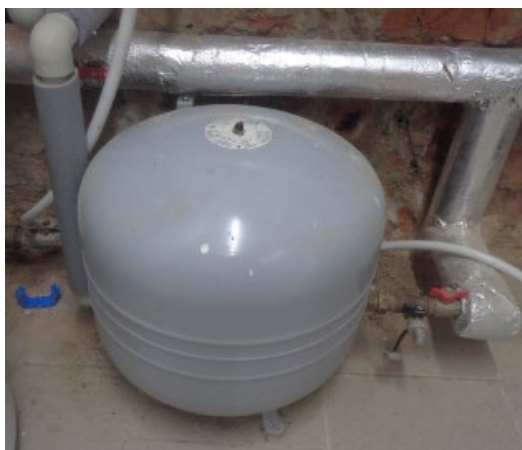
Obrázek č. 24 - Expanzomat není ukotven
