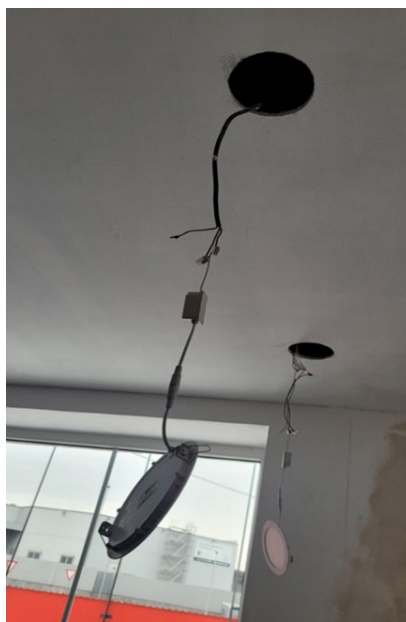
Obrázek č. 15 - Volně visící používané kabely pod napětím
